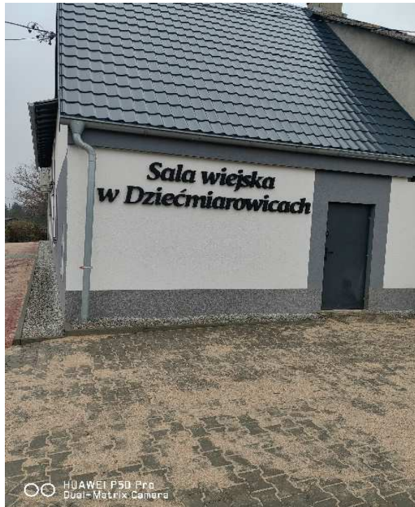
Zdjęcie 25 Sala wiejska w Dziećmiarowicach
