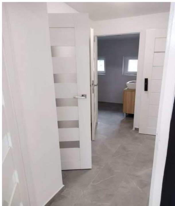
Zdjęcie 26 Sala wiejska w Dziećmiarowicach
