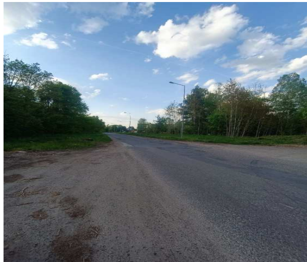
Zdjęcie 8 Rozbudowa ul. Akacyjowej w Wiechlicach
