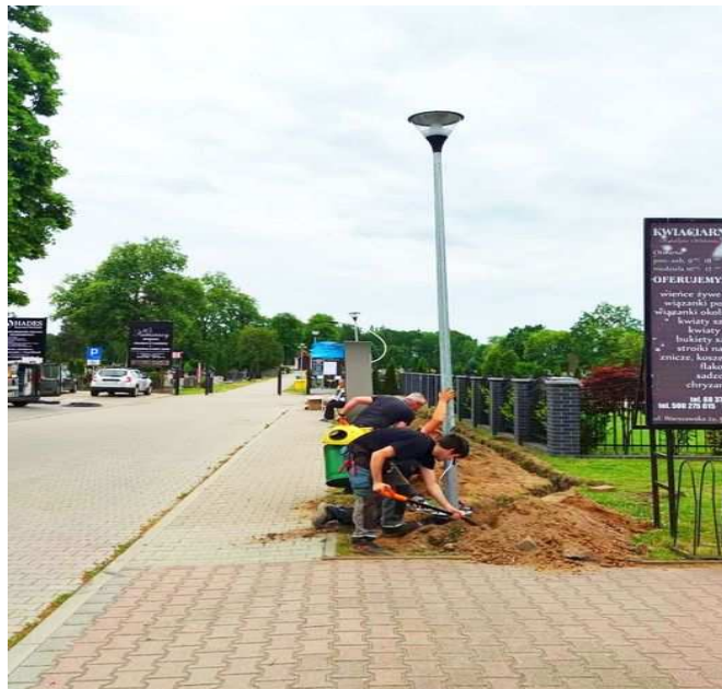
Zdjęcie 53 Montaż oświetlenia przy cmentarzu komunalnym w Szprotawie
