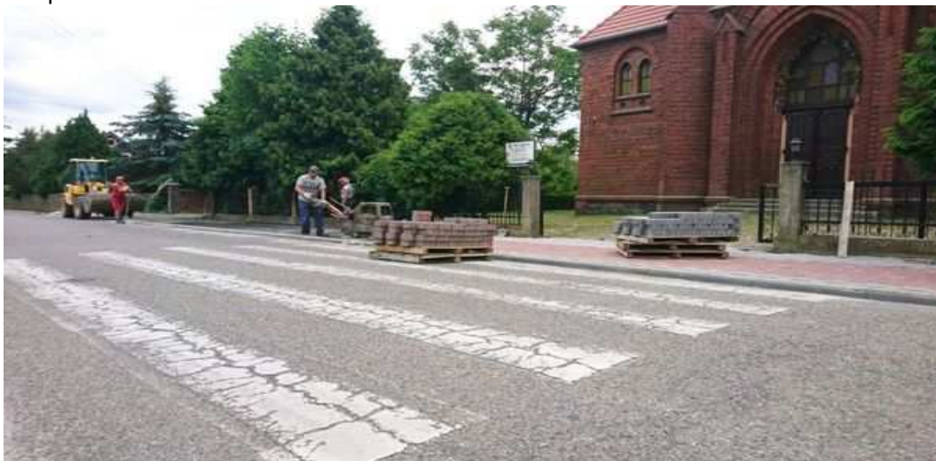
Zdjęcie 22 Budowa chodnika w Długiem
