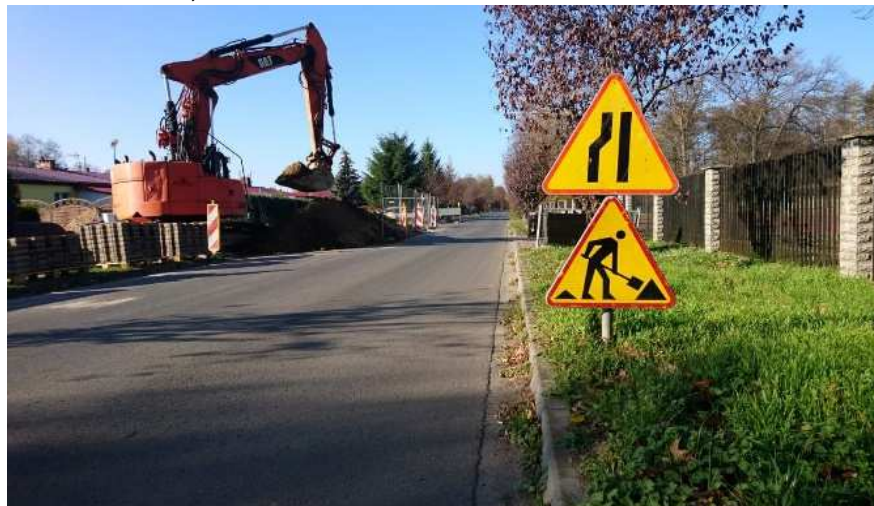
Zdjęcie 10 Rozbudowa ul. Brzozowa i ul. Klonowa
