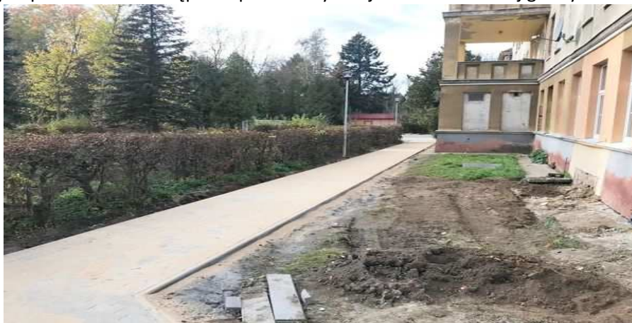
Zdjęcie 51 Teren Szpitala - remont chodników
