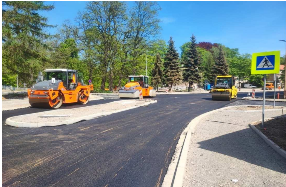
Zdjęcie 4 Przebudowa części ul. Basztowej i B. Kozaka
