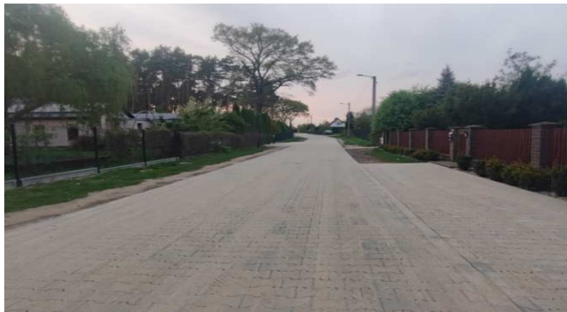
Zdjęcie 13 Budowa ul. Kasprzaka
