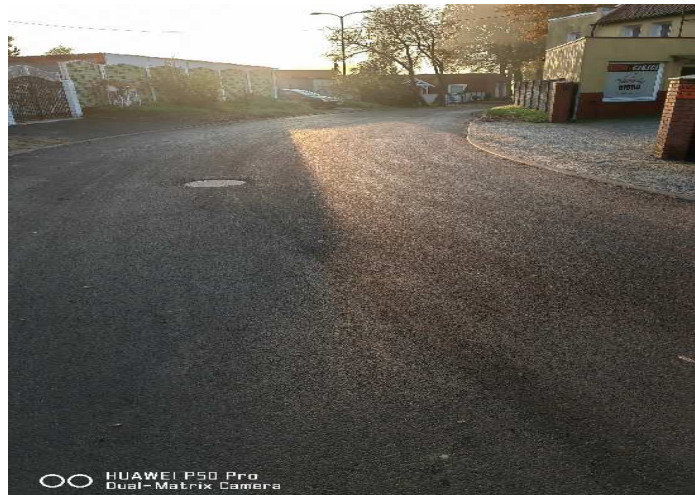
Zdjęcie 18 Modernizacja ul. Dębowej
