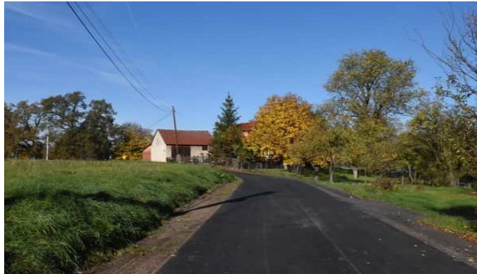
Zdjęcie 17 Modernizacja ul. Polnej
