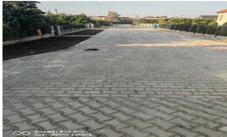
Zdjęcie 19 Przebudowa ul. Sikorskiego i ul. Krótkiej
