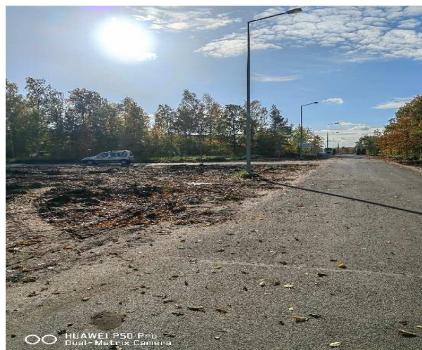
Zdjęcie 9 Rozbudowa ul. Akacyjowej w Wiechlicach
