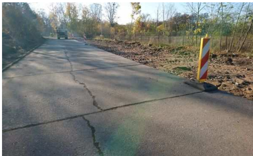
Zdjęcie 11 Rozbudowa ul. Brzozowa i ul. Klonowa
