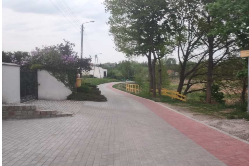
Zdjęcie 12 Przebudowa ul. Poniatowskiego
