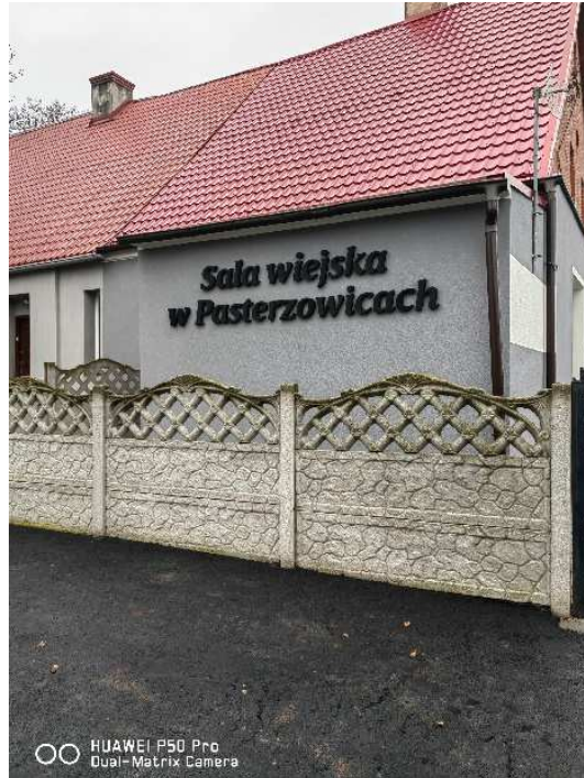
Zdjęcie 29 Sala wiejska w Pasterzowicach
