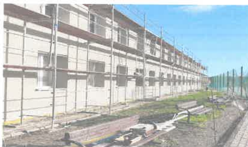
Zdjęcie 13 Termomodernizacja budynku Szkoły Podstawowej w Lesznie Górnym
