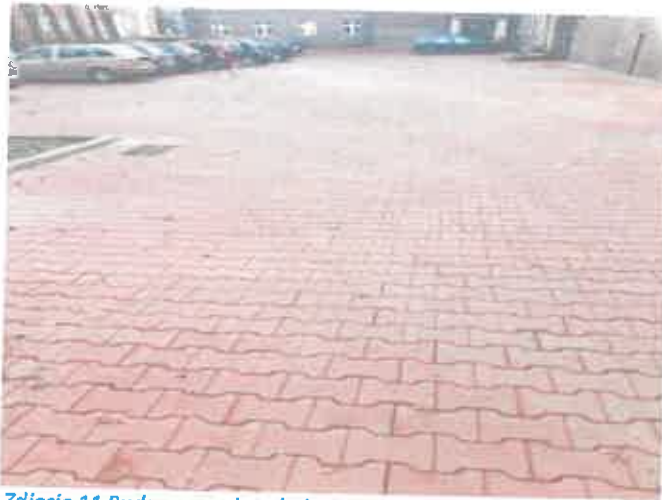
Zdjęcie 11 Budowa nawierzchni przy Liceum Ogólnokształcącym
