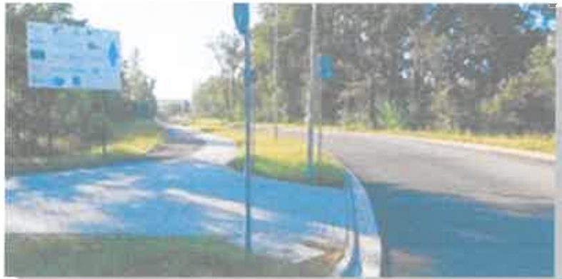
Zdjęcie 4 Rozbudowa drogi gminnej ul. Akacjowa - Wiechlice
