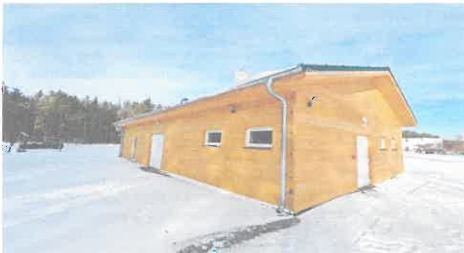
Zdjęcie 9 Budynek rekreacyjny w Szprotawce
