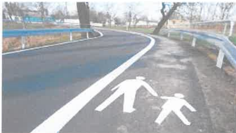
Zdjęcie 7 Budowa nawierzchni drogi w Lesznie Górnym
