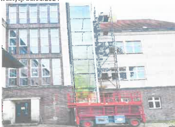
Zdjęcie 10 Montaż windy dla osób niepełnosprawnych w Liceum Ogólnokształcącym
