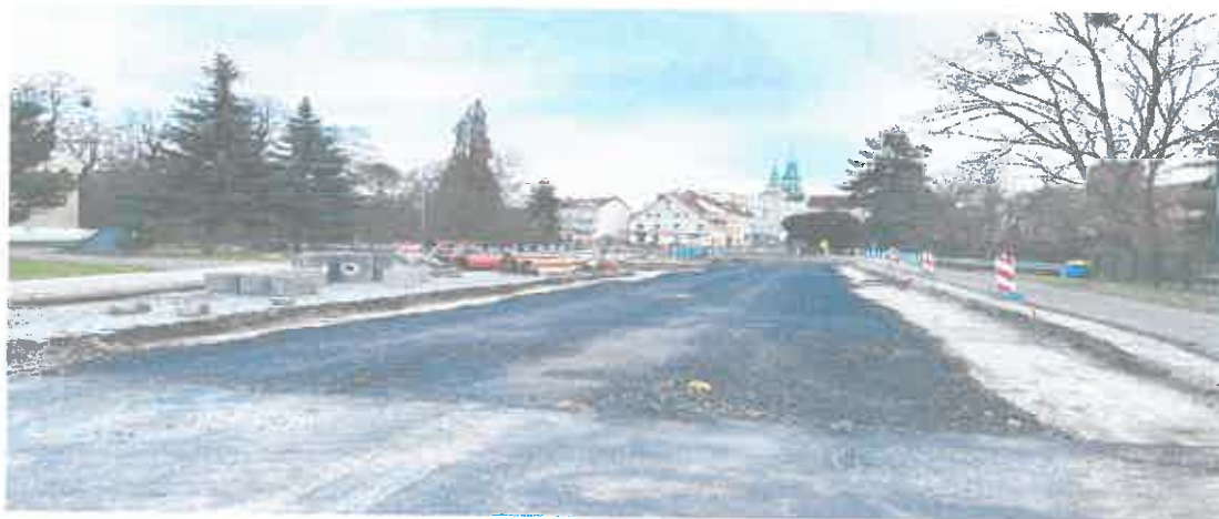
Zdjęcie 6 Rozbudowa ul. Mickiewicza
