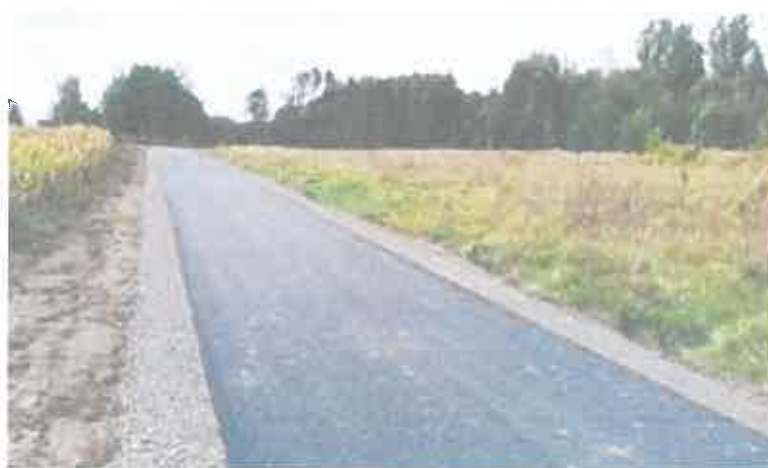
Zdjęcie 3 Modernizacja drogi dojazdowej
