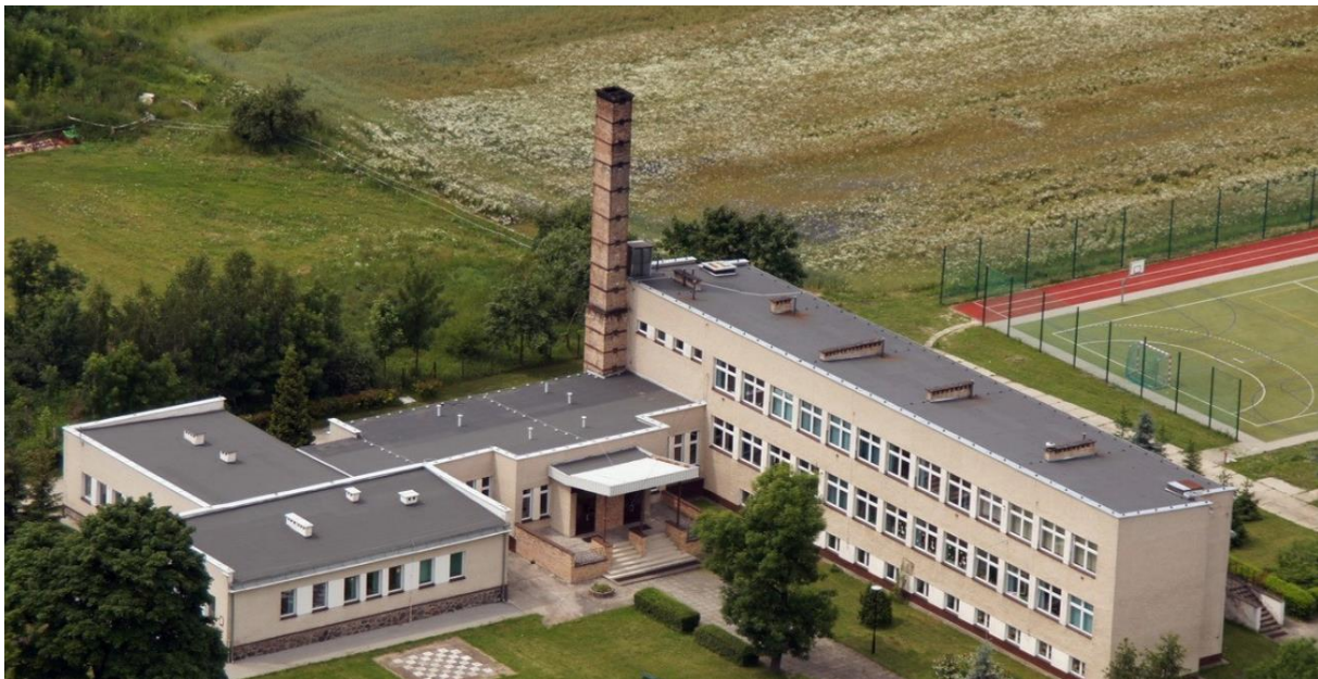
Zdjęcie 6 Zdjęcie budynku Szkoły Podstawowej w Długiem
