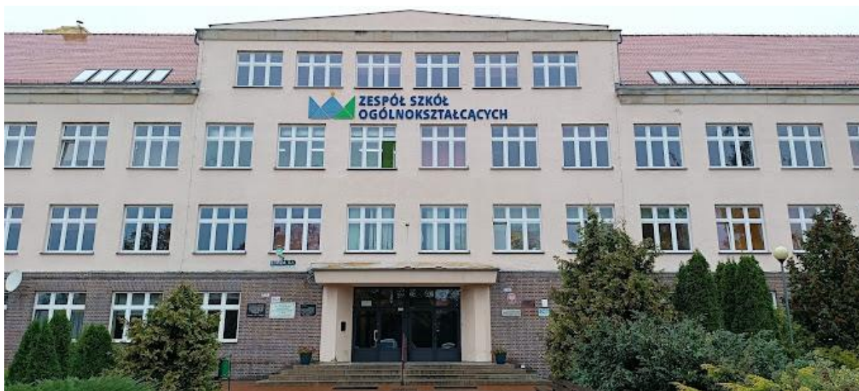
Zdjęcie 7 Zdjęcie budynku Liceum Ogólnokształcącego w Szprotawie
