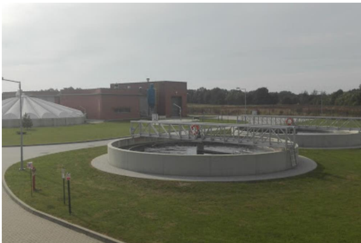
Zdjęcie 19 Oczyszczalnia ścieków w Wiechlicach
