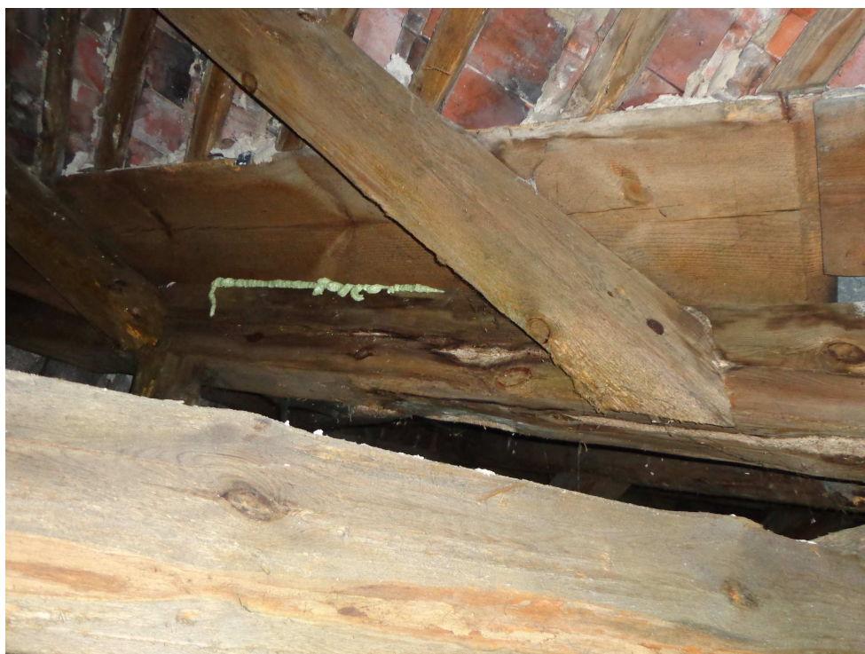
Prowizoryczne uszczelnianie pokrycia, więźba dachowa uszkodzona poprzez degradację biologiczną.
