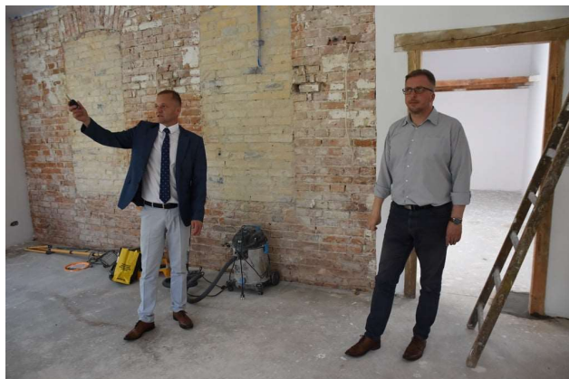
Modernizacja pomieszczeń biurowych Spółki CHROBRY
