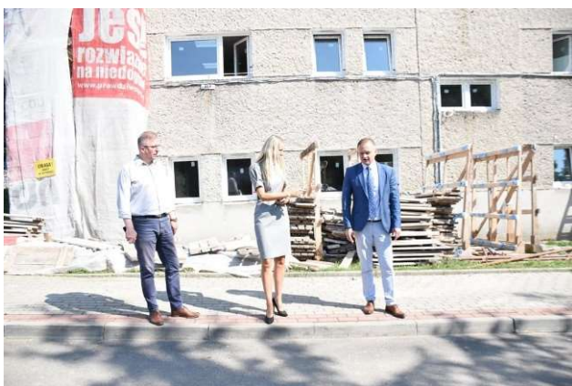
Termomodernizacja budynku SzWiK
