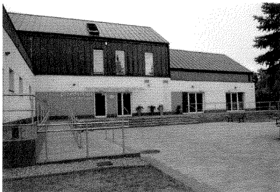
budynek Przedszkola od strony wejścia
